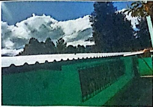
Foto 3: Lamina troquelada calibre 26 en el modulo
